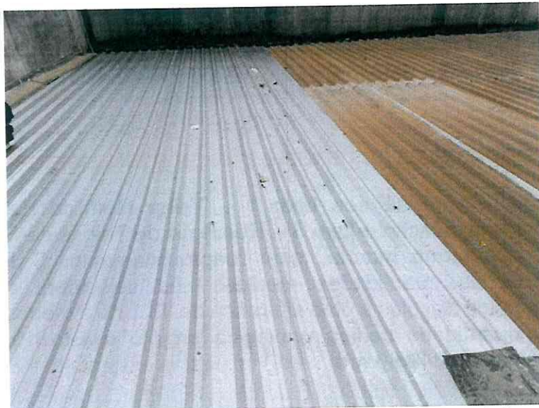
Imagem 03 – Substituição de telhas metálicas termoacústicas
